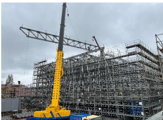
【体育館棟】13tのアリーナのトラス梁を架けています。
