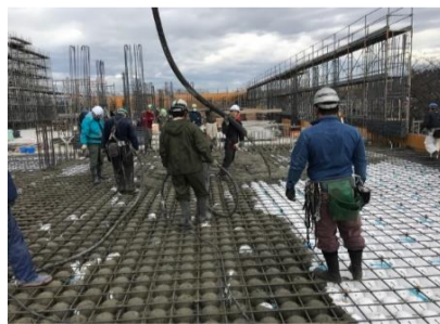
コンクリートの打設です。
