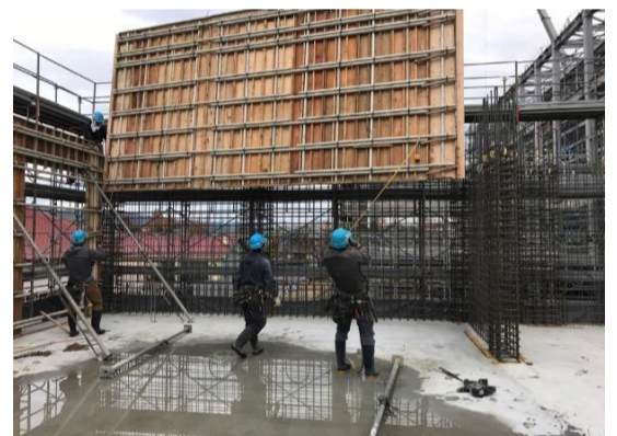
【管理棟】壁型枠の一面を地組みして建て込みます。
