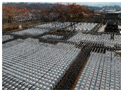
ボールボイドを敷設して、鉄筋を組立てします。
