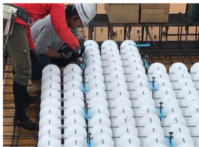
ボールボイドを敷設して、鉄筋を組立てします。
