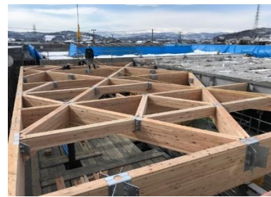
金物にドリフトピンを打込み固定します。
