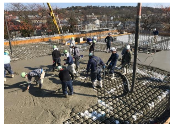
【校舎棟】1階躯体の鉄筋と型枠を組立て、数回に分けてコンクリートを打設します。
