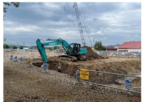
【産振棟】基礎根切り工事中です。
