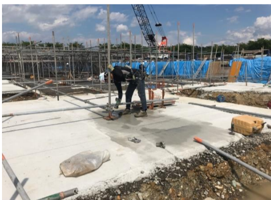
【体育館棟】【管理棟】基礎の足場、鉄筋及び型枠の組立中です。
