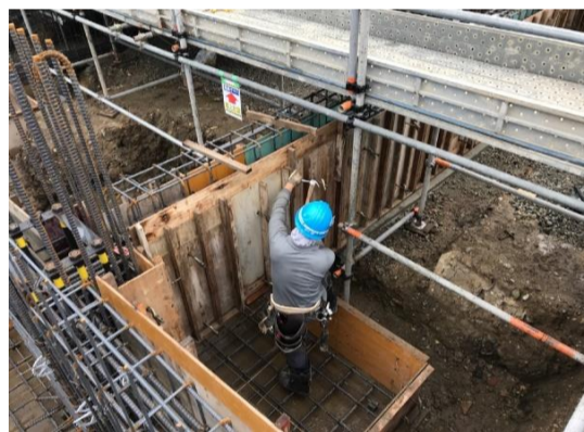
【体育館棟】【管理棟】基礎の足場、鉄筋及び型枠の組立中です。
