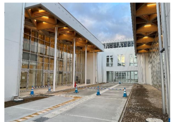
【校舎棟】昇降口まわりの外構工事もまもなく完成です。
