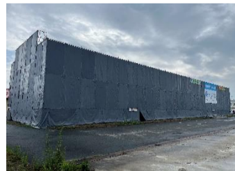
防音シート設置
