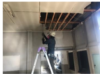
内装材の解体
