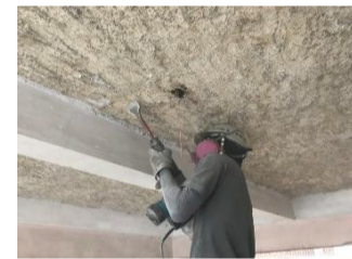
躯体打込断熱材の撤去
