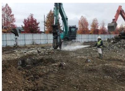
周囲を掘削してから基礎を解体していきます。解体中は、粉じんの飛散防止も忘れずに。
