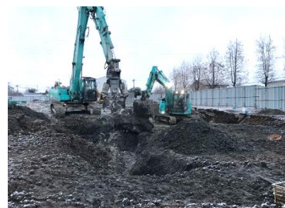
基礎、土間も縁切りしながら慎重に解体していきます。
