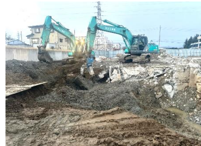
基礎、土間も縁切りしながら慎重に解体していきます。
