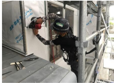
「外壁の張替え」
