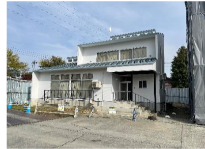
「改修後の外観」
